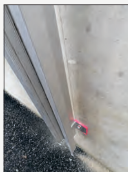
Profili a cassetta in alluminio estruso
