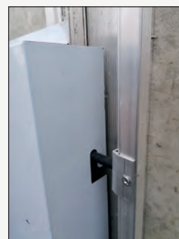
Fissaggio dei pannelli ai profili
