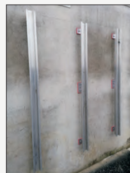
Fissaggio dei pannelli ai profili
