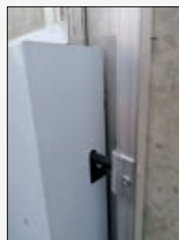
Fissaggio dei pannelli ai profili
