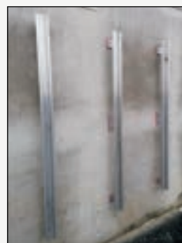
Fissaggio dei pannelli ai profili
